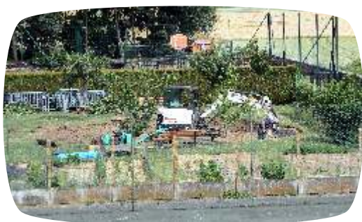
Construction d'une yourte contemporaine pour répondre à l'urgence de la situation et pour, de fait, retrouver un espace dédié à la garderie périscolaire.
