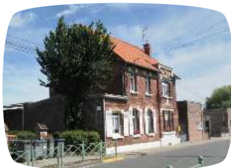
Travaux d'entretien du patrimoine communal (maison de l'ancien directeur d'école)
