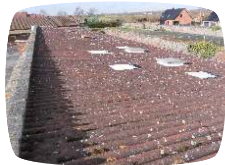
Rénovation de la toiture de l'école.
