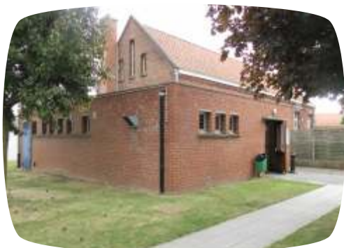
Création d'une nouvelle "cantine" au foyer communal pour les "grands" de l'école.
